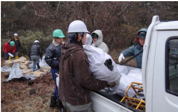
軽トラックでの資材の運搬
