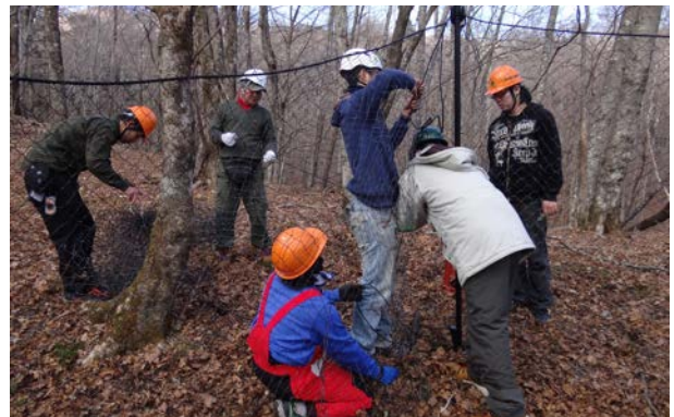
柵の設置作業
