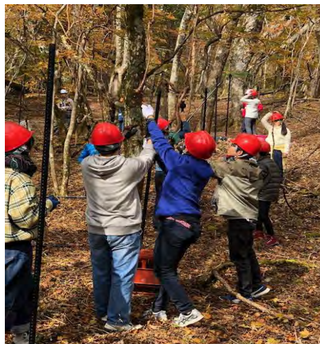
常葉大学との鹿柵設置作業
