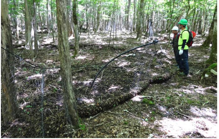
No.2 雪代による土石流で破損 (2018)
